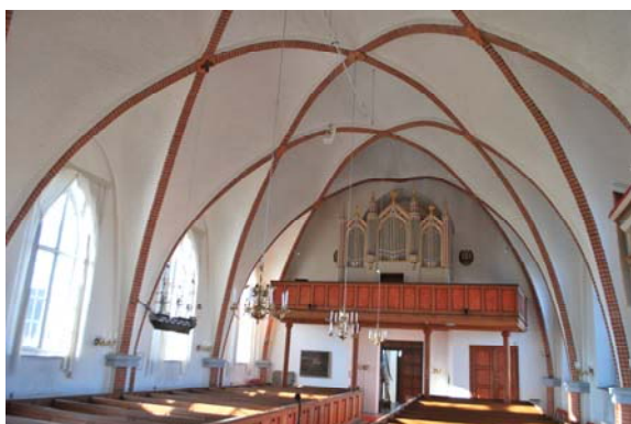
Mot orgelläktaren i väster.
