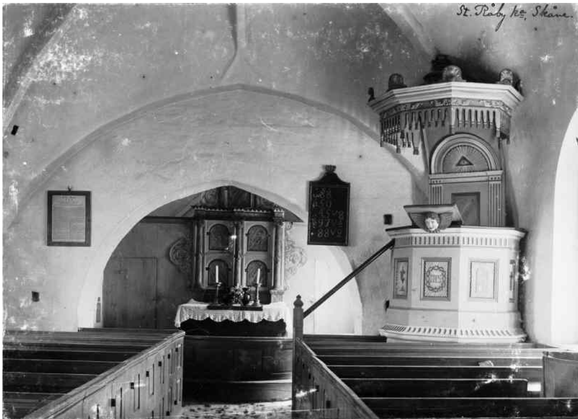
Innan restaureringen 1909 hade kyrkorummet slutna bänkkvarter.
