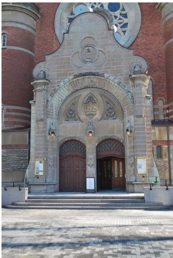
Fasad mot väster. Huvudingången.
