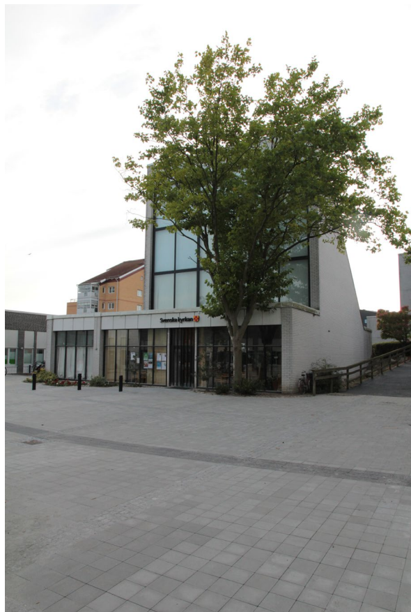
Linero torg efter ombyggnad.
