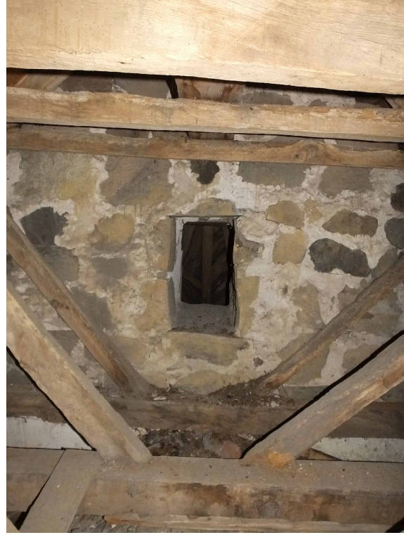
Ursprunglig öppning mellan kor och absid. Till höger syns nedtill i korgaveln den inmurade bjälken.
