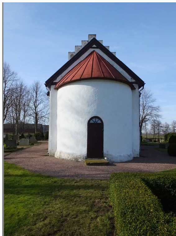
Tornet från sydväst och absiden sedd från öster. I korets östra gavel syns en inmurad bjälke som är en rest av en äldre taklagskonstruktion. Absidtaket är utfört utan hänggränna eller fotränna vilket är ett traditionellt utförande.
