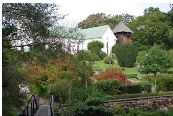
Fasad mot sydväst.
