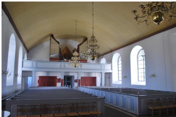
Långhuset mot orgelläktaren i öster.
