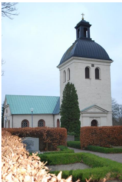
Tornet och tvärskeppet från väster.
