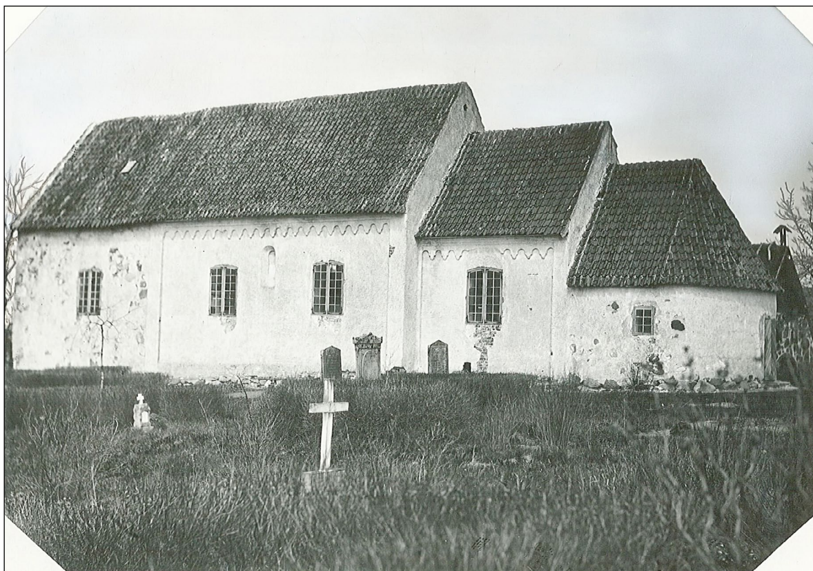
Den romanska kyrkan fotograferad strax innan rivning. Mitt på långhusets fasad syns ett högt sittande romanskt fönster, vilket sattes igen när de större småspröjsade fönstren installerades på 1700-talet.
