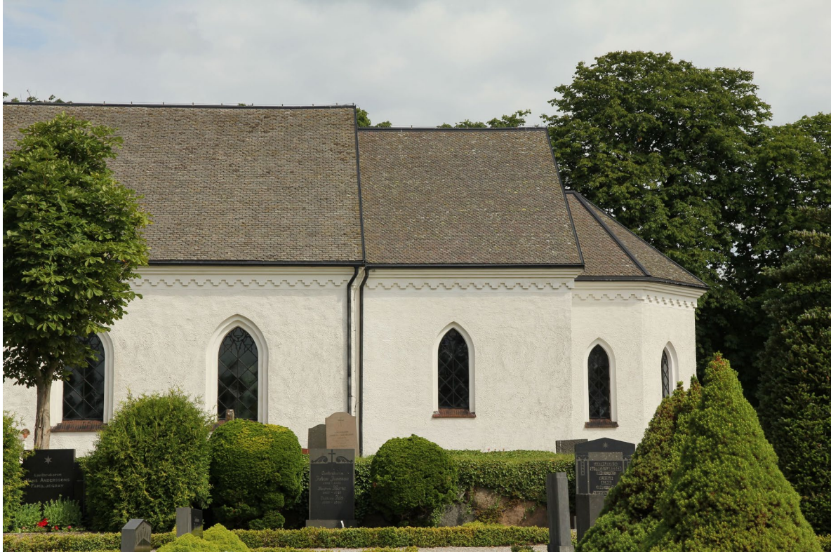
Taken över långhus, kor och absid är belagda med skiffer. Fönstren har en tidstypiskt spetsbågig form, vilken kännetecknar den nygotiska arkitekturen.
