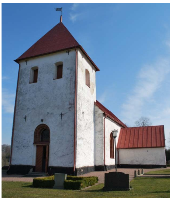
[1]: Tornet och södra vapenhuset från sydväst
