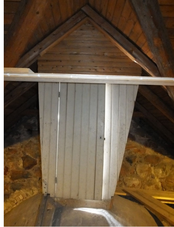
På vinden finns en inbyggnad för ett ljusschakt till koret som idag är igensatt.
