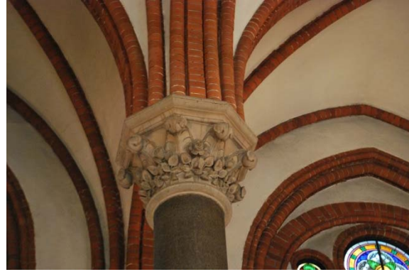
Granitkolonn med cementkapitäl.
