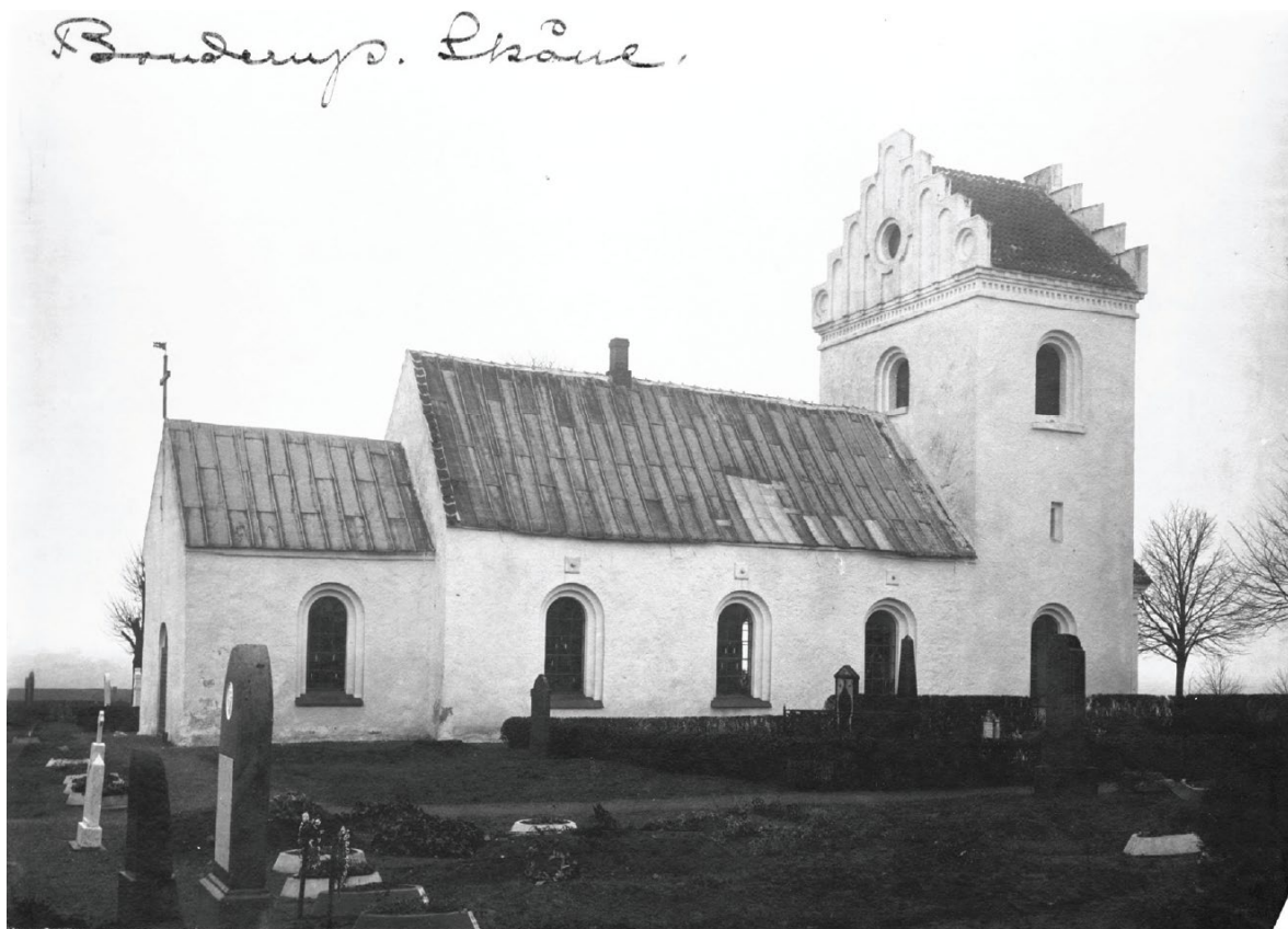
Fotografi taget av Theodor Wählin innan stormen 1916. Långhuset och korets tak var belagda med blyplåt. De ljusare plåtarna på långhustakets nedre parti var lagningar i galvaniserad plåt.
