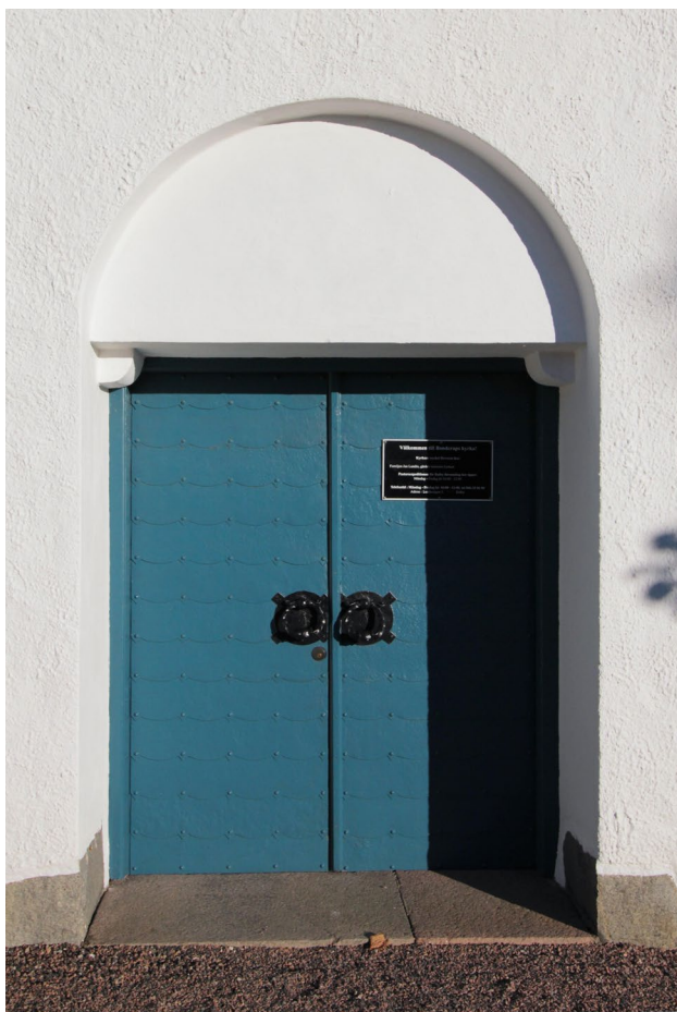
Västrentréns dörr bär medeltidsromantiska drag och ritades av Wählin.
